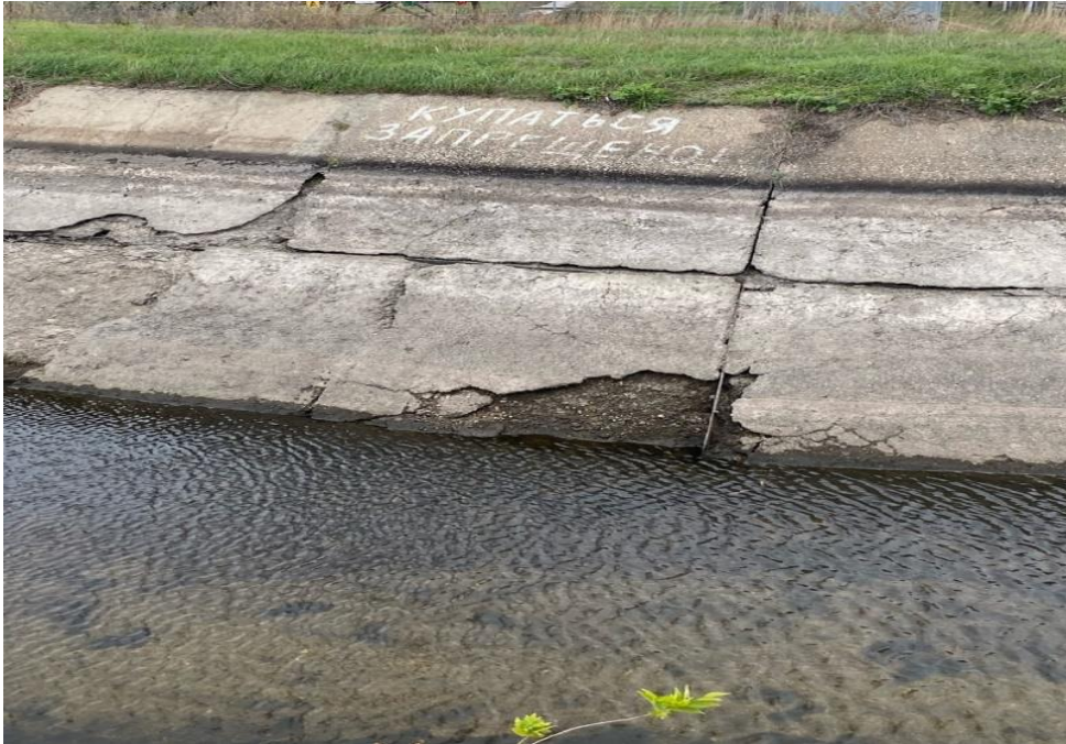
Рисунок 2.1 – Техническое состояние облицовки оросительных каналов при длительной эксплуатации
