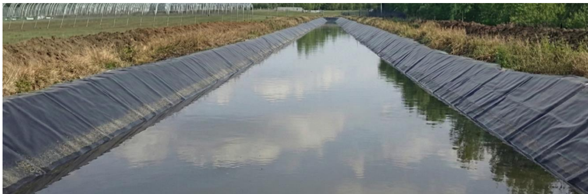
Рисунок 4.1 - Композитный материал «Каплам», уложенный как облицовка оросительного канала
