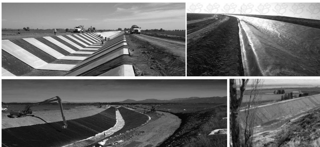
Рисунок 1.9 – Проводимые работы по обновлению облицовки оросительных каналов
